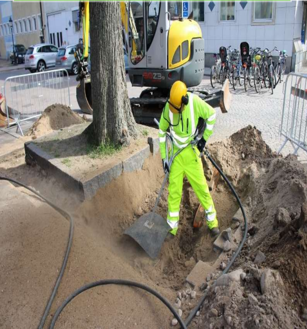
Rotkartering med grävmaskin och tryckluft!
