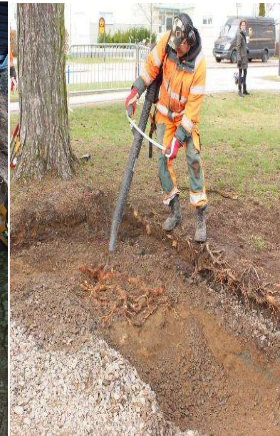
Skonsam schakt med lövblås
