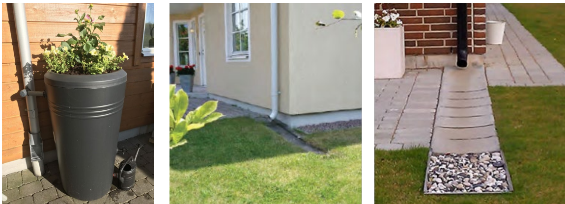
Figur 15 Regntunna och stuprör med rännal, foto Alingsås kommun och Nordvästra Skånes Vatten och Avlopp.
