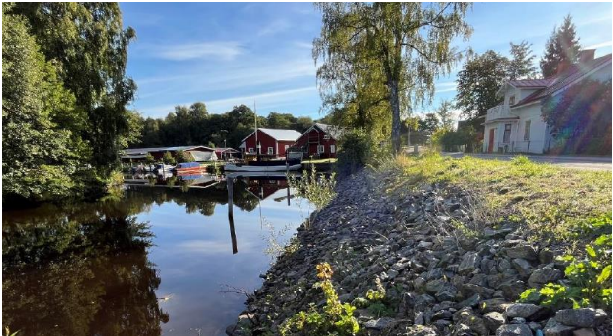
Bild över anlagda erosionsskydd. Ångbåtsföreningen i bakgrunden.
