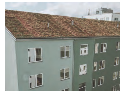
Gröna tak fördröjer dagvatten och bidrar till biologisk mångfald
