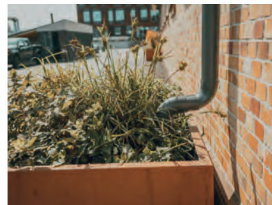
Regnvatten från tak kan ledas ner och fördröjas i regnbäddar
