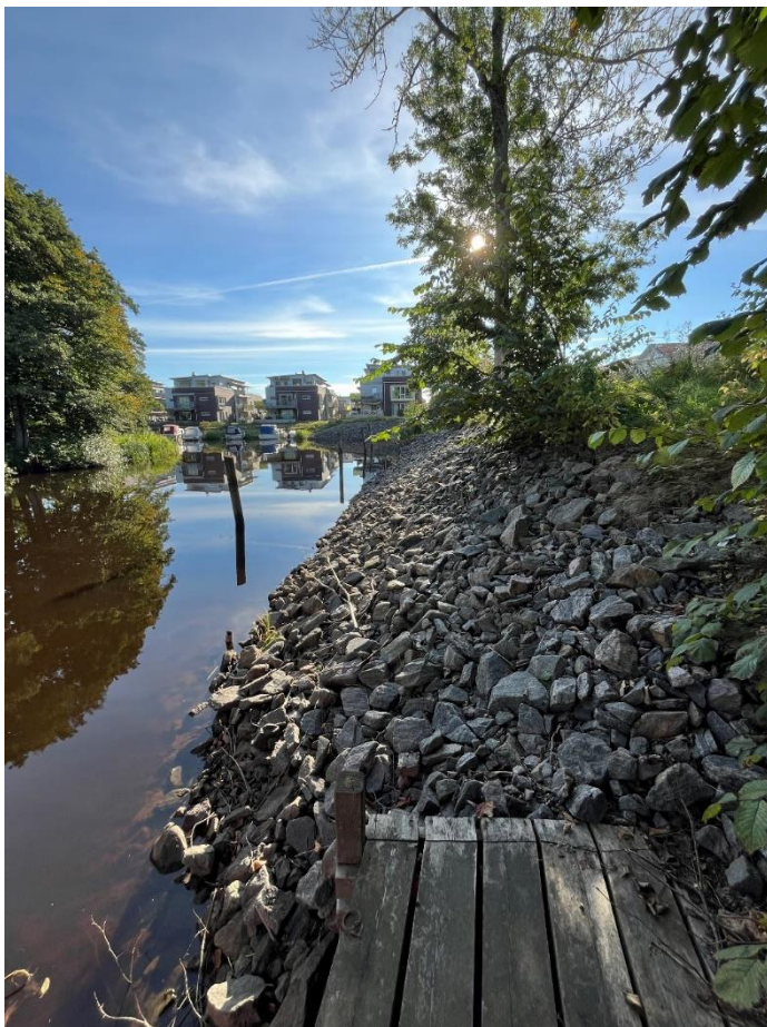
Figur 10. Erosionsskydd uppströms Mjörns Ångbåtsförening.
