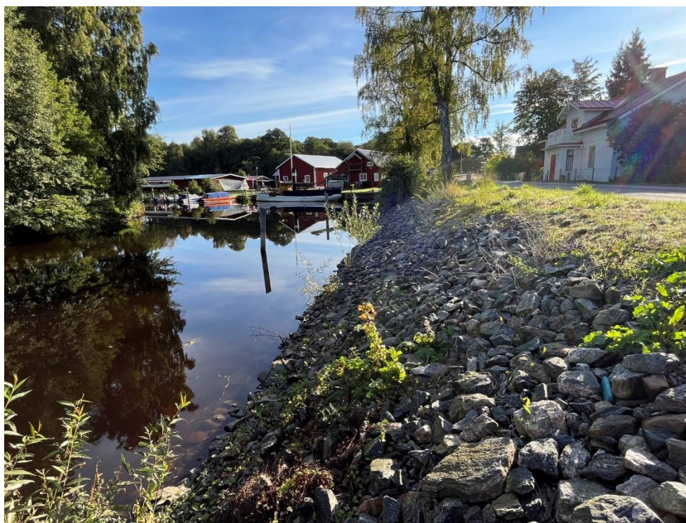
Figur 9. Erosionsskydd nedströms Mjörns Ångbåtsförening.
