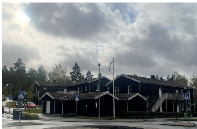
Befintlig bebyggelse vid korsning Trollskogsgatan-Stadsskogsgatan, fastigheten Sagoskogen 1
