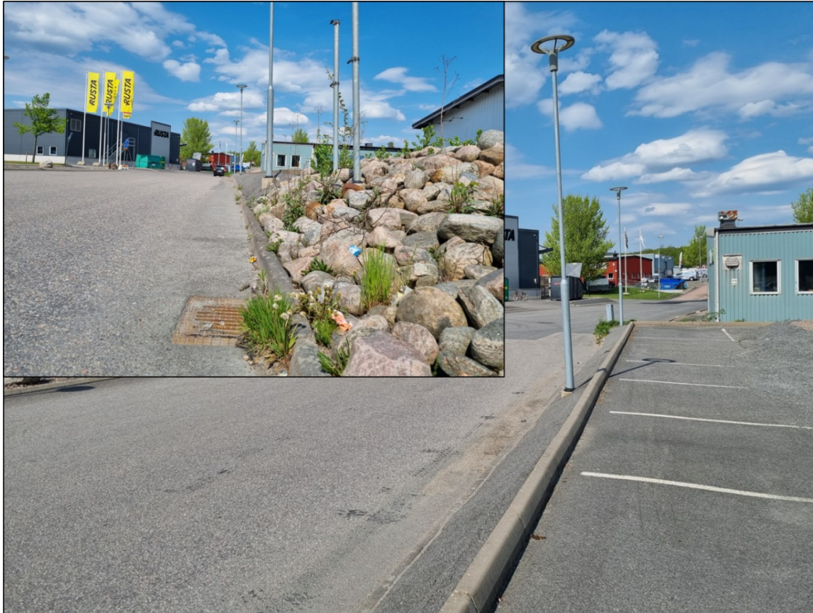
Figur 29. Observation av upphöjd fastighet från platsbesök (2023-05-15). (Foto: Norconsult)
