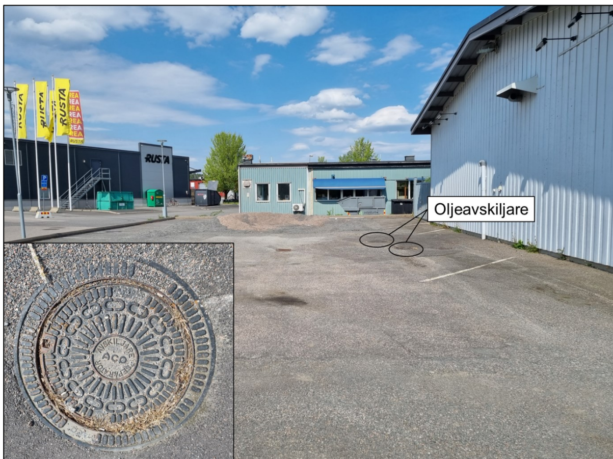
Figur 7. Oljeavskiljare observerad vid platsbesök (2023-05-15). (Foto: Norconsult)
