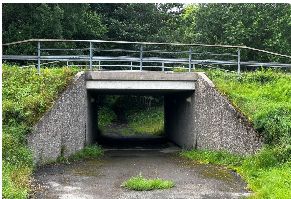
Figur 18. Nulägesbild av gångtunneln under Kärrbogärdevägen mot det södra planområdet.
