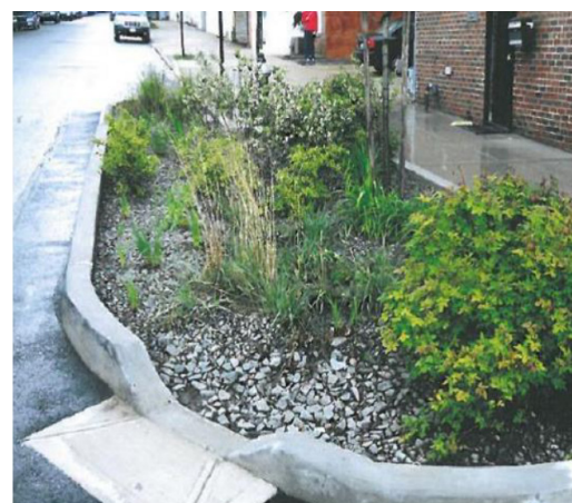
Exempel på biofilteranläggningar (Sweco 2023).
