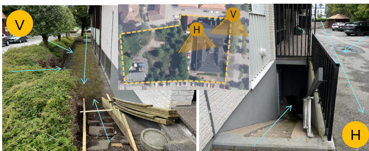
Figur 8: Vänster bild visar stenplattor mellan vegetation och fasad med stuprör som går direkt ner i marken.
