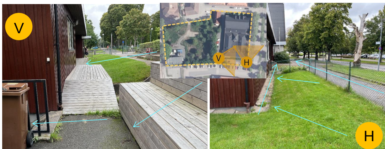
Figur 10: Vänster bild visar förskolegård med lutning mot fasad. Höger bild visar gräsytor från fasad mot Landskyrkoallen. Stuprör är kopplade direkt ner i marken.
