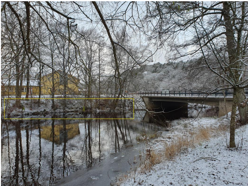
Figur 8. Nedströms från brofästet på västra sidan, åtgärdsområde 1, markerat i gult.
