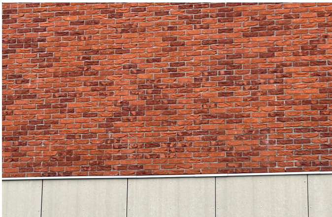
Ventilerad tegelfasadsystem. Greenstorage i Borås
