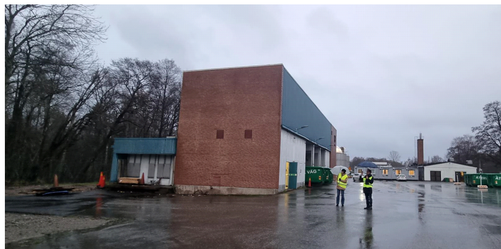
Den befintliga verkstadsbyggnadens rena tegelgavlar bidrar till att ge den befintliga anläggningen en viss karaktär, trots att helhetsintrycket spretar en hel del.
