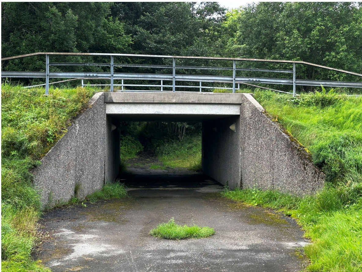
Figur 8 Bilden visar gångtunneln under Kärrbogärdevägen.
