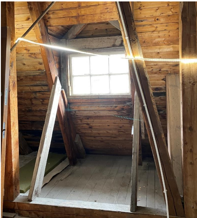
Ett av de två mindre och ursprungliga vindsfönstren åt öster.
