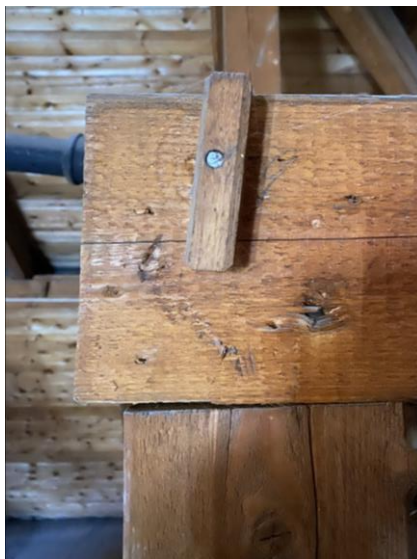
Den omålade takkonstruktionen med sotarluckan och träklyka på ohyvlat bräda.
