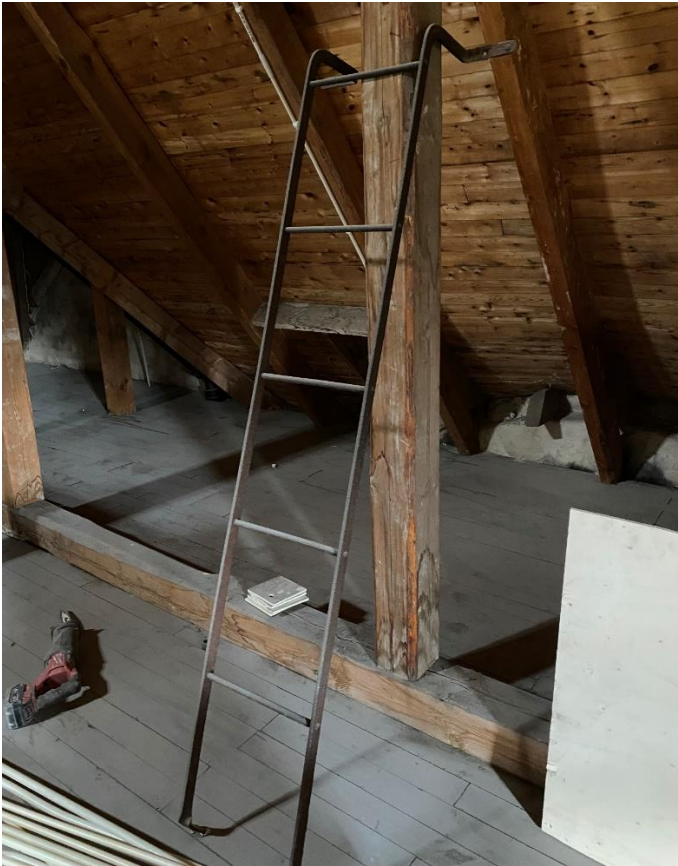
Utvändig takstege i smide som kan återanvändas i inredningen.
