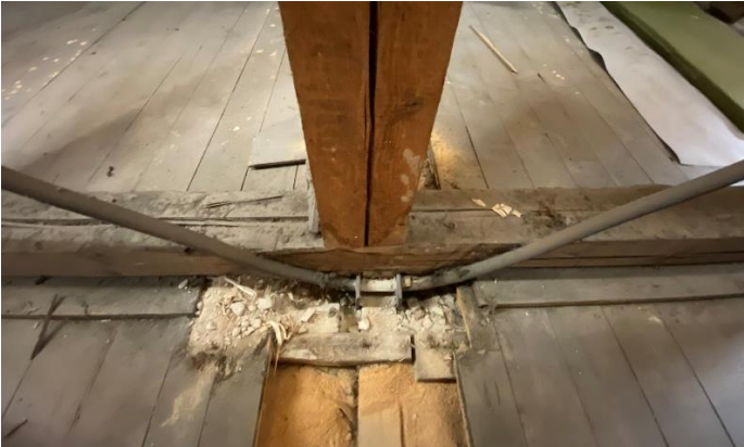
Metallstagg som utgör en del av konstruktionen.
