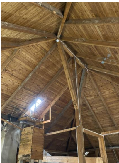
Den omålade takkonstruktionen med sotarluckan och träklyka på ohyvlat bräda.
