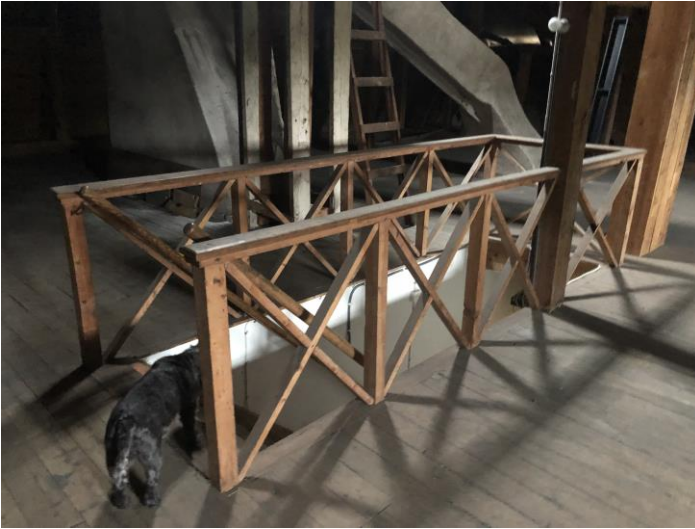
Ursprungligt träräcke runt vindstrappan som rekonstrueras för entresolplanen.
