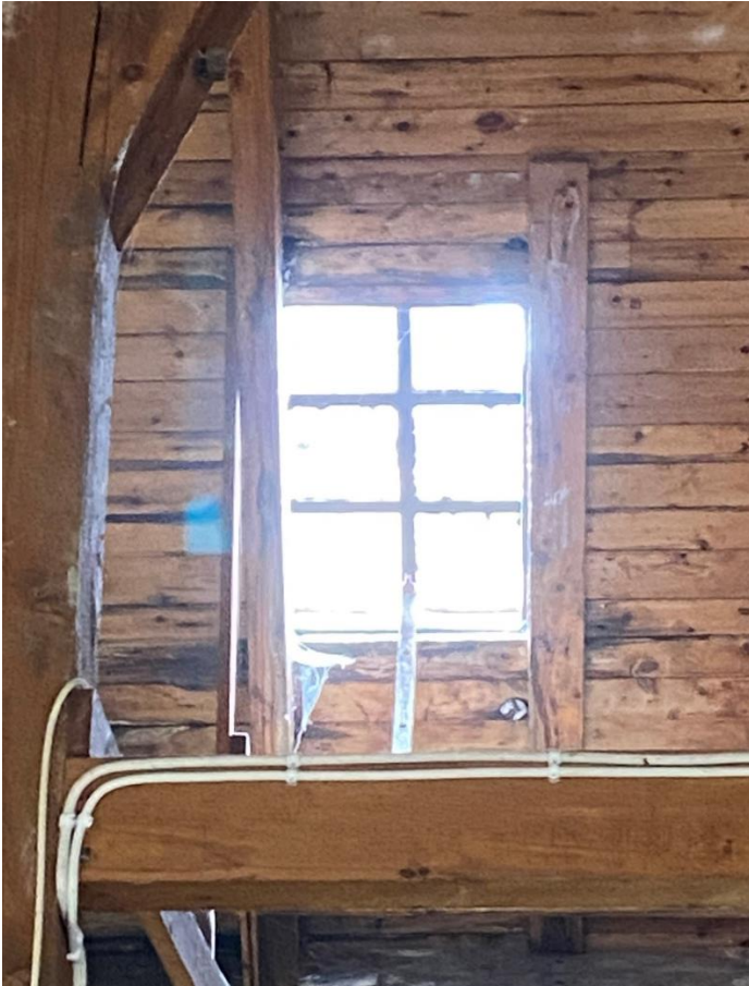
Sotarluckan med öppnings- och stängningsjärn nertill.
