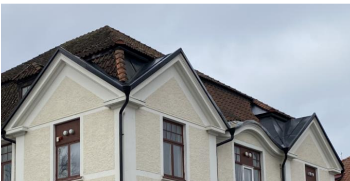
Gatufasaden åt öster med de ursprungliga mindre takkuporna med avvalmat sadeltak i det nedre takfallet. Frontespiserna kröns med sadeltak som avslutas med en avvalmad gavelspets upptill.
