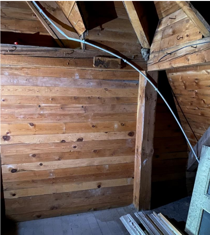
Inuti hörnförrådet i det nordöstra hörnet.
