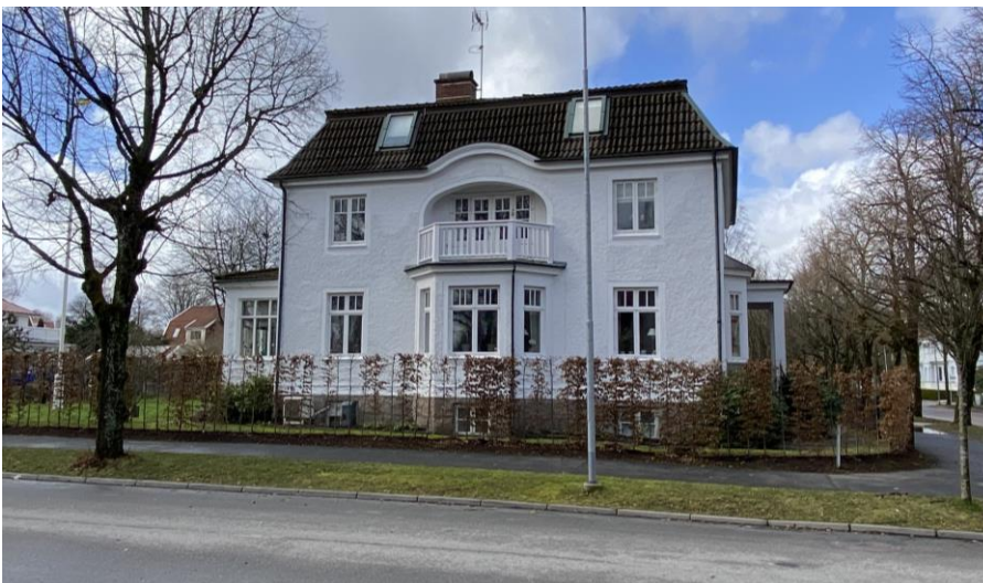
Takfönster på en annat kulturhistoriskt värdefullt byggnad i ett intilliggande kvarter.
