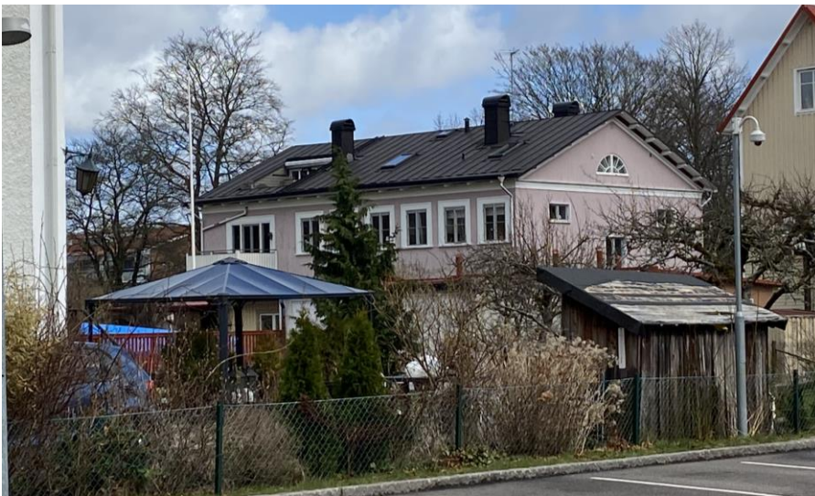
Indragen takterrass och takfönster inåt trädgården i en byggnad med högt kulturhistoriskt värde inom kulturmiljön Sörhaga.
