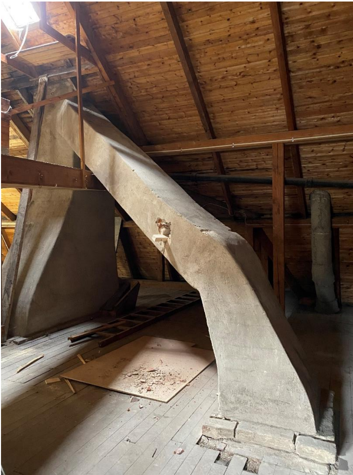
Murstocken bibehålls och putsas. Den tillhörande rökkanalen kommer att tas bort då den är i ett skick som gör att den inte är möjlig att bevara.
