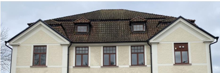
Gatufasaden åt öster med de ursprungliga mindre takkuporna med avvalmat sadeltak i det nedre takfallet. Frontespiserna kröns med sadeltak som avslutas med en avvalmad gavelspets upptill.
