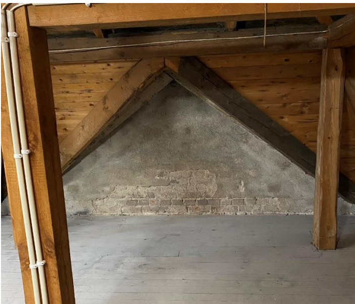
Murat parti med putsat offerskikt som utgör baksidan av trekantsgavlarna som kröner frontespiserna.
