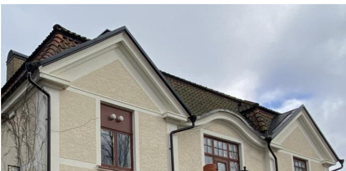
Den norra sidan (överst) som har bandfalsad svart plåt intill fronstespisens sadeltak av plåt och den södra gaveln (nederst) som har taktegel intill sadeltaket av plåt.
