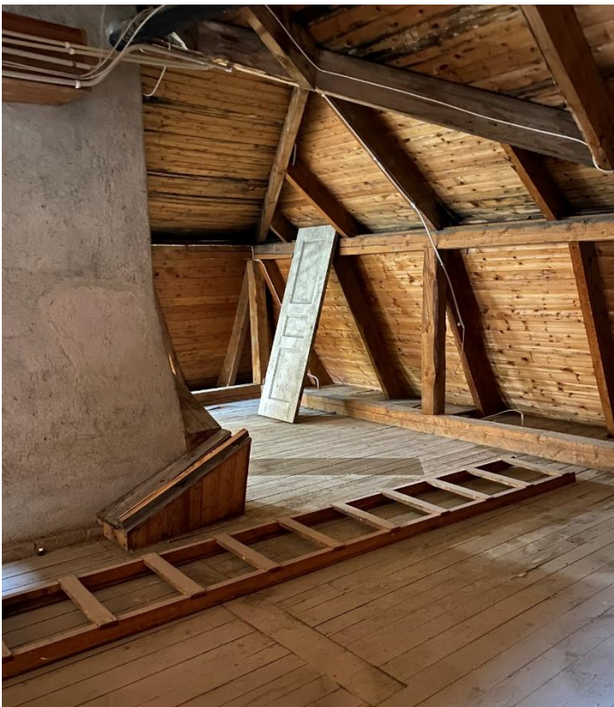
Trästege upp till sotarluckan som bevaras och kan återanvändas i inredningen på annan plats.
