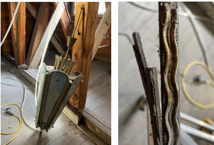
Stor, ovanlig taklampa med spegelglas och metall. Tunna dekorlister av trä med guldfärg som suttit som en övergång mellan tapet och nermålat tak. Dessa kan återanvändas på lämplig plats.
