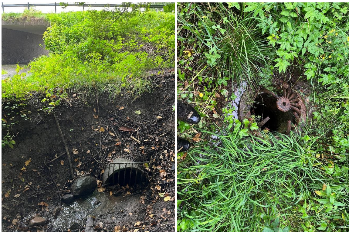
Figur 3-2: Till vänster visas bäckens utflöde från planområdet genom en 400-trumma där den sedan fortsätter som rörlagd bäck fram till recipienten. Till höger visas trasig kupolbrunn.
