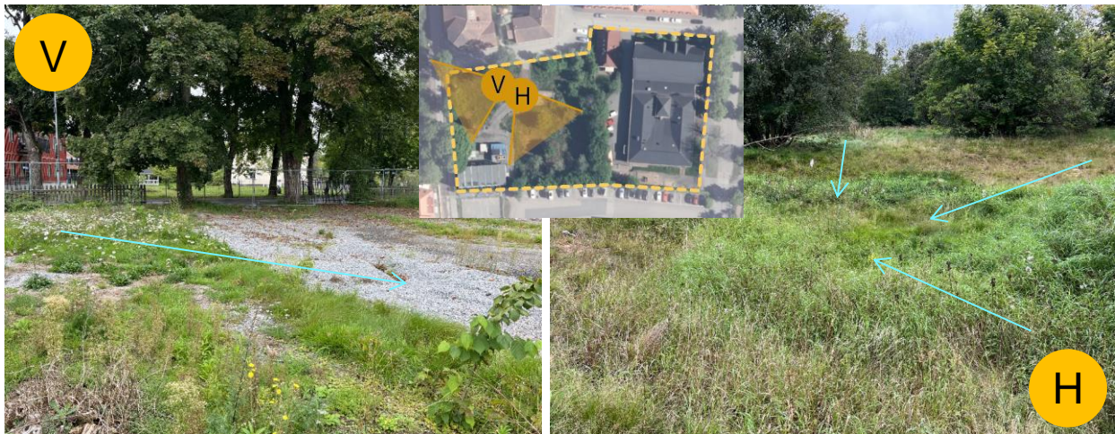
Figur 3: Vänster bild visar vy mot Prästgårdsvägen från Afzelligatan 2. Höger bild visar lågpunkt inom samma fastighet.
