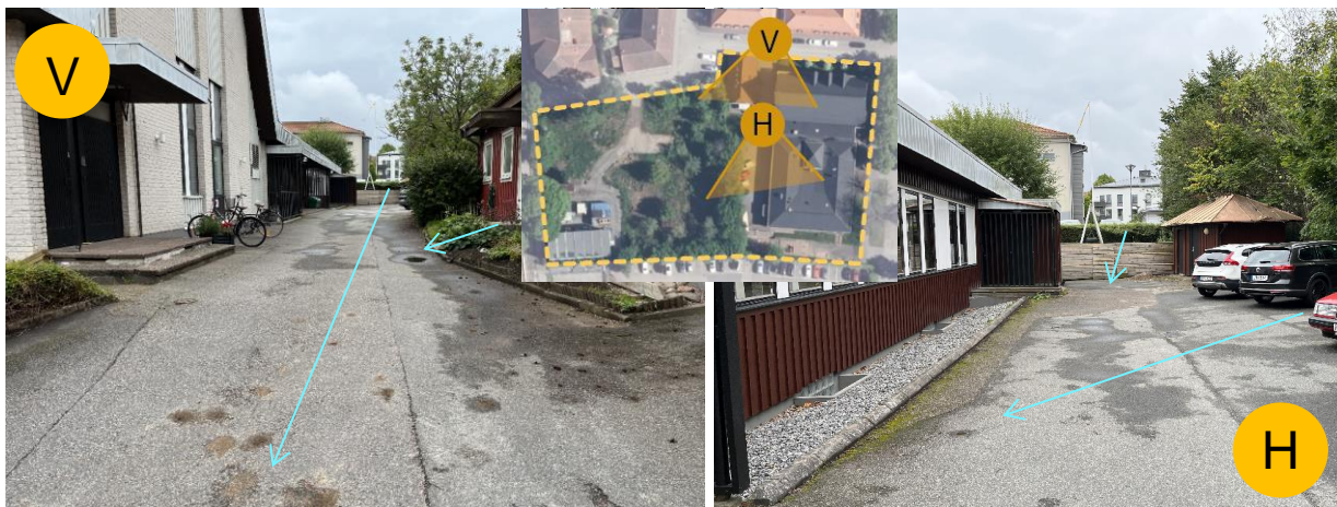
Figur 7: Vänster bild visar asfalterad passage mellan byggnader. Höger bild visar lutning från parkering och grusyta vid fasad. Stuprör är kopplade direkt ner i marken.
