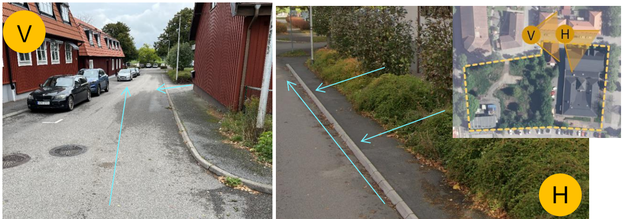
Figur 6: Vänster bild visar Brunnsgatan. Rännstensbrunnar finns lokaliserade under bilarna. Höger bild visar fastighetsgränsens gräns mellan vegetation och gångbana. Stuprör är kopplade direkt ner i marken.
