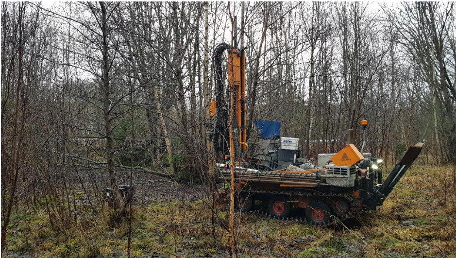
Figur 3. Borring vid Skr2308SW, där det dels framgår hur tätt beväxt nordöstra delen av området är. Provpunkten behövde flyttas några meter pga betongfundament.
