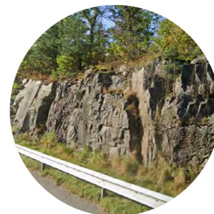
Bild: Exempel på exponerat sprängt berg mot allmän plats, Alingsås. Google maps street view, jan 2023.
