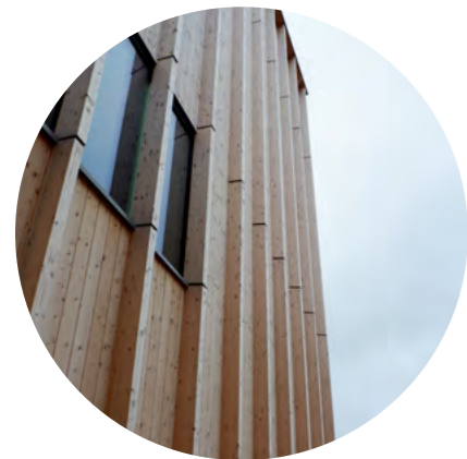
Bild: Sara Kulturhus, ritad av White. Exempel på träfasad med vertikal indelning i fasad. Liljewall.
