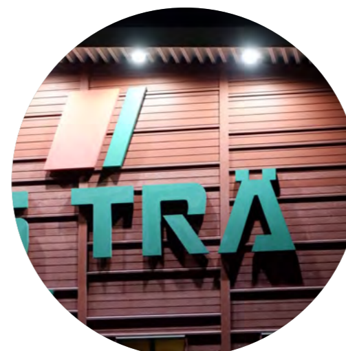
Bild: Exempel på kombinerad fasad- och skyltbelysning som är nedåtriktad Liljewall.
