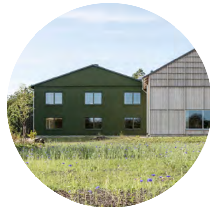
Bild: Exempel på byggnader som med monokrom färgsättning och enhetligt fasadmaterial. Kaminsky Arkitektur.
