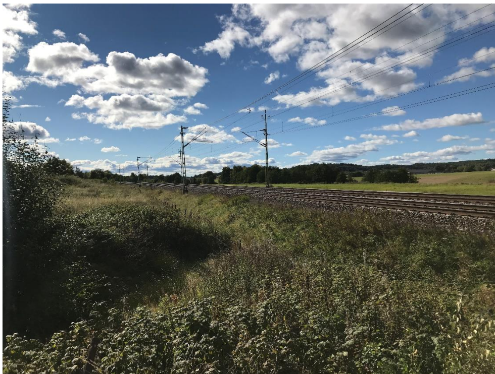
Figur 5. Foto av det västra delområdet, där fotot är taget mot väster över Västra stambanan där Säveån går bakom skogsområdet (COWI 2022-09-20).
