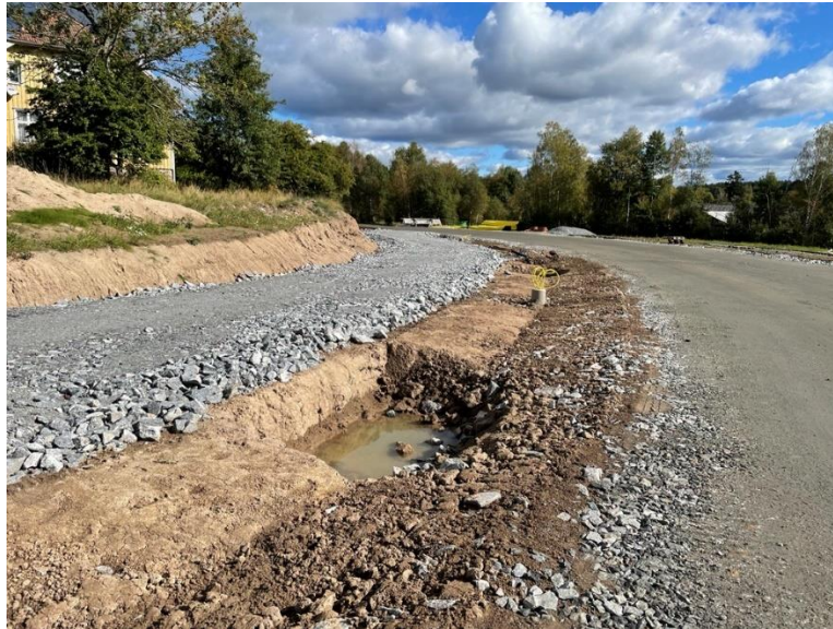
Figur 9. Byggnation av ny lokalgata från Stockholmsvägen (COWI 2022-09-20).
