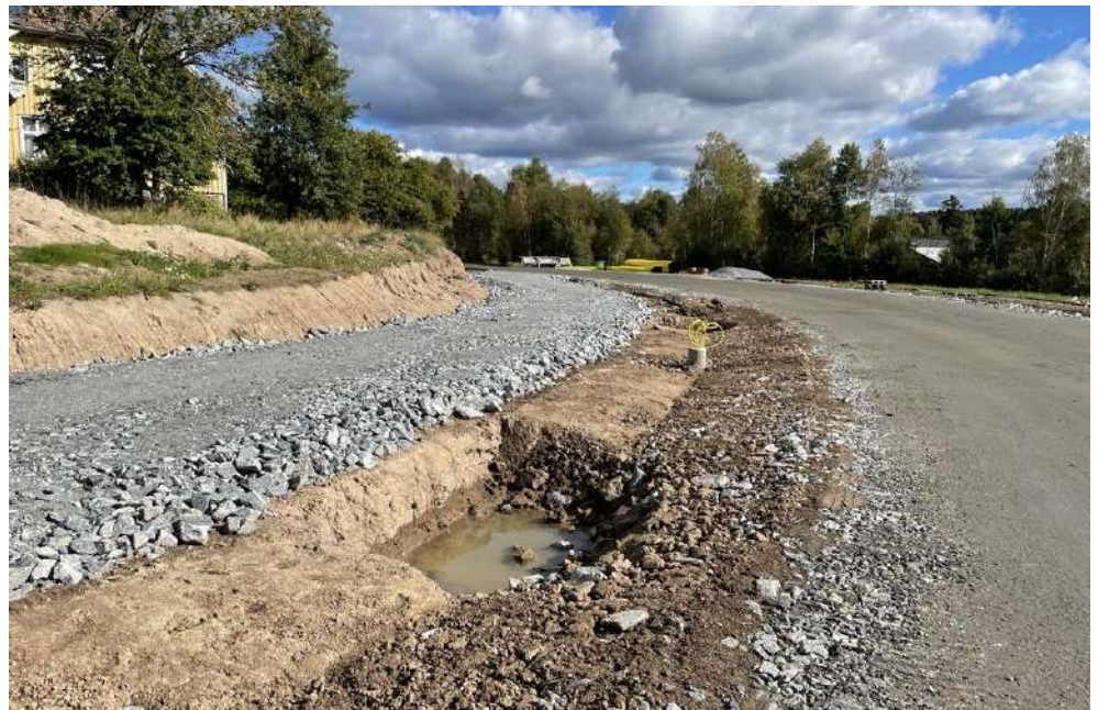
Figur 10 Byggnation av ny lokalgata från Stockholmsvägen och Etapp 1 (COWI 2022-09-20).
