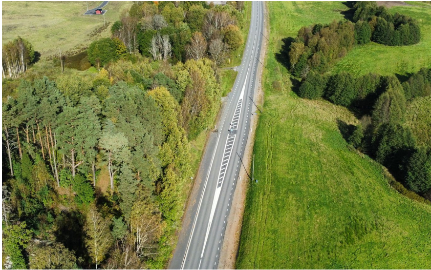
Figur 12. Översiktsbild över Stockholmsvägen där gång- och cykelbanan övergår genom en passage till väggrensseparatorer för gående och cyklister
