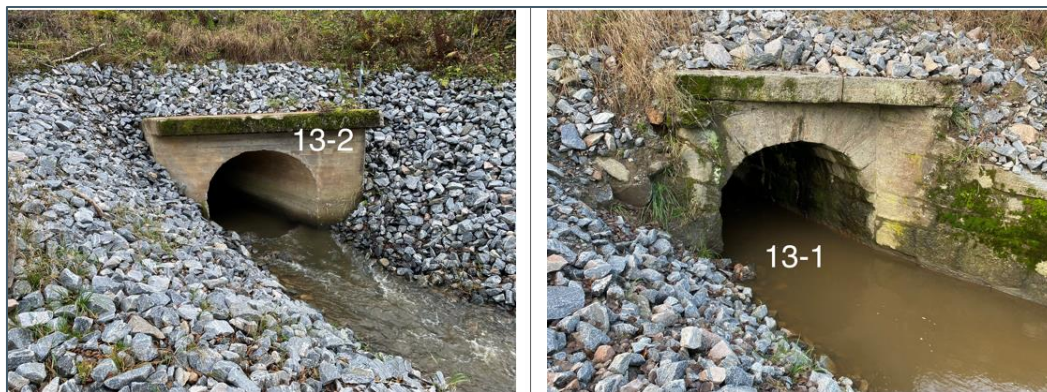
Figur 12. Stentrumma under stambanan norr om planområdet är en 1700 Ø med bakfall. Uppskatta kapacitet 1000 l/s.
