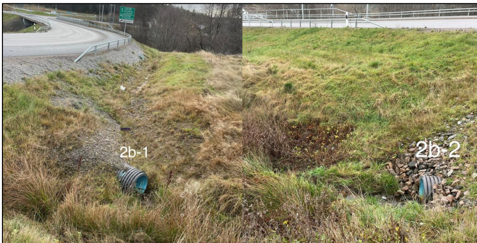
Figur 18. Trumman under Stockholmsvägen, öster om befintlig cirkulationsplats. Maxkapacitet 600 l/s.
