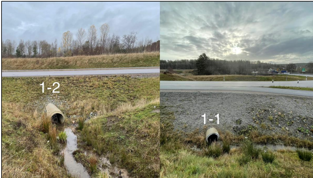
Figur 18. Trumman under Stockholmsvägen, öster om befintlig cirkulationsplats. Maxkapacitet 600 l/s.
