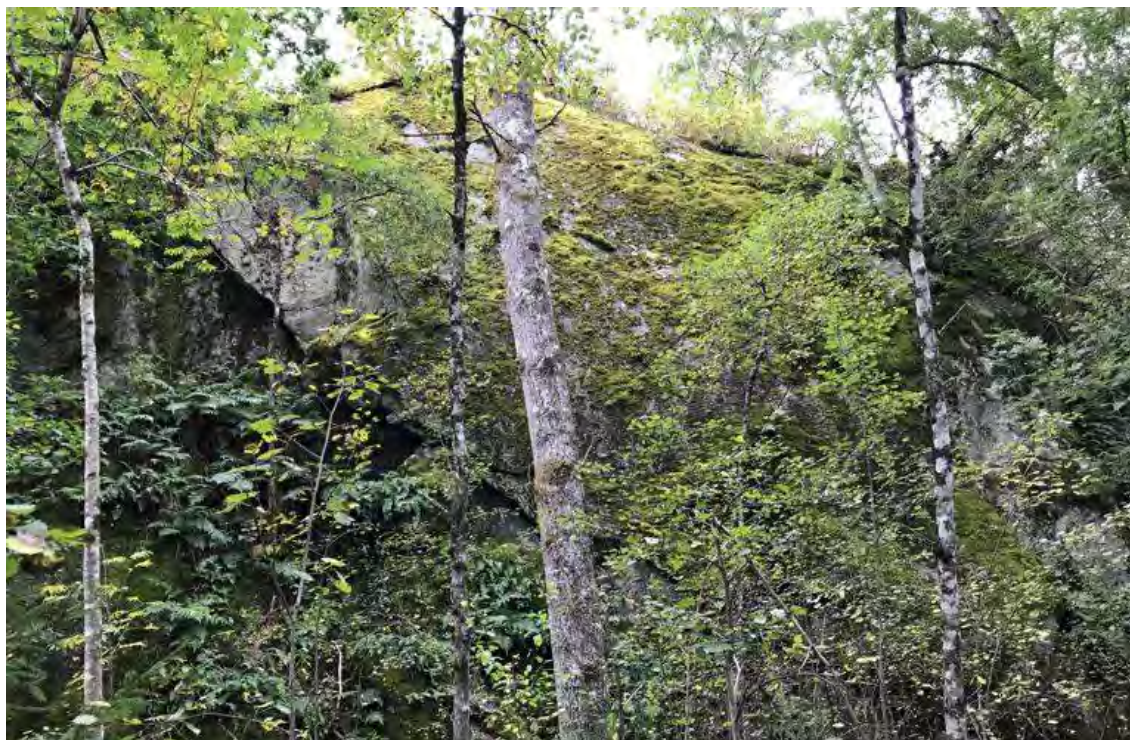
Figur 11. Hög bergsslänt med rasbrant nedanför.
