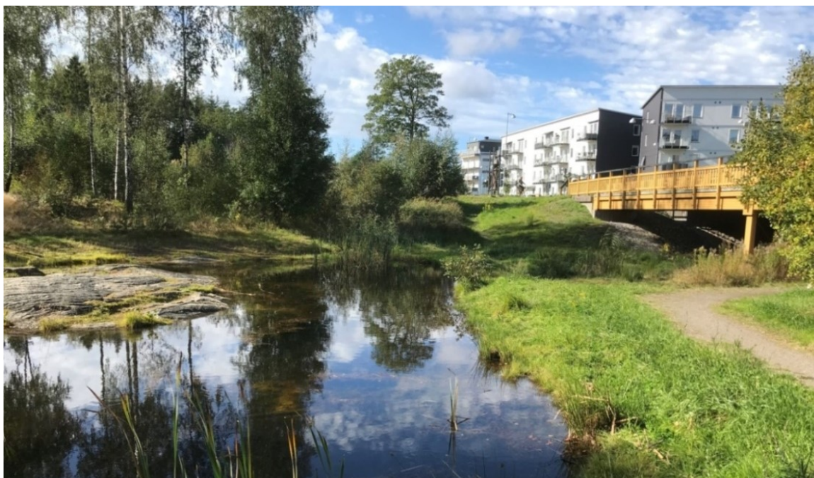
Förutom att rena och fördröja vatten kan dagvattenlösningar bidra till estetiska och hälsofrämjande livsmiljöer, samt till biologisk mångfald (Dagvattendammar i Stadsskogen). Foto Kretsloppsavdelningen.
