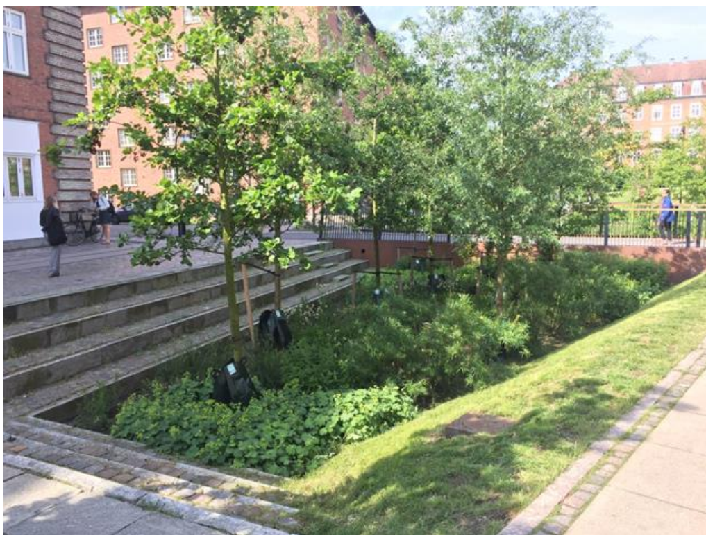
Öppen, grön hantering av dagvatten i Köpenhamns första klimatanpassade stadsområde, Tärsinge Plads. Här har 1000 kvm oanvänd asfalt omvandlats till en grön oas där dagvatten från ca 8000 kvm fördröjs. På så sätt frigörs utrymme i befintligt dagvattensystem vilket minskar risken för översvämningar i händelse av skyfall. Dagvattenanläggningen bidrar även med flertalet ekosystemtjänster till området. Foto Sweco Environment.
