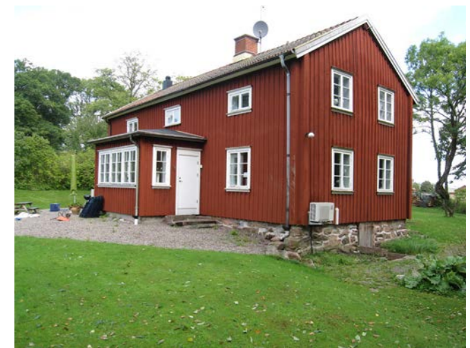
Flygelbyggnad vid Östad säteri.
