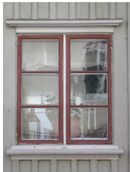
Äldre renoverat fönster med handblåsta glas.
