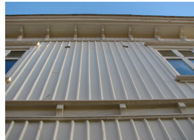
Panelarkitektur med stående locklistpanel och profilsågade detaljer på listverk.
