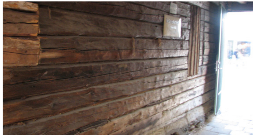
Timrad vägg i portgången till Kronan 3.
