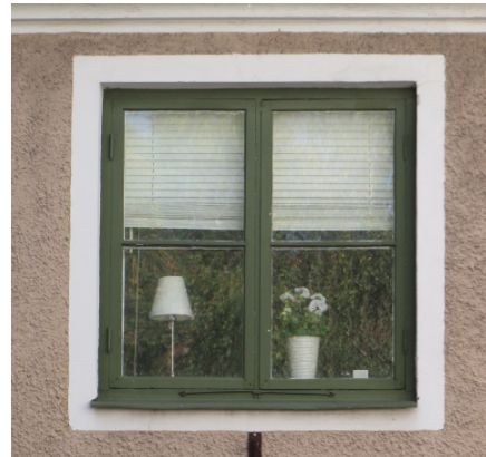
Ursprungligt fönster i kvarteret Pelikan.
