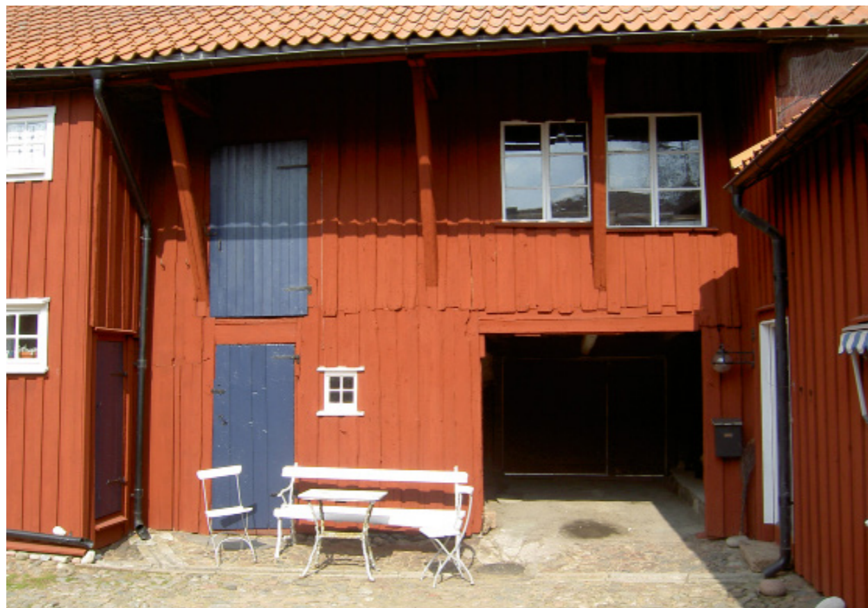
Gårdsbebyggelse i kvarteret Hästskon. Vanligt förekommande färgsättning i staden var att gårdsbyggnaderna slammades röda och fasaderna mot gatan målades i ljus linoljefärg.
