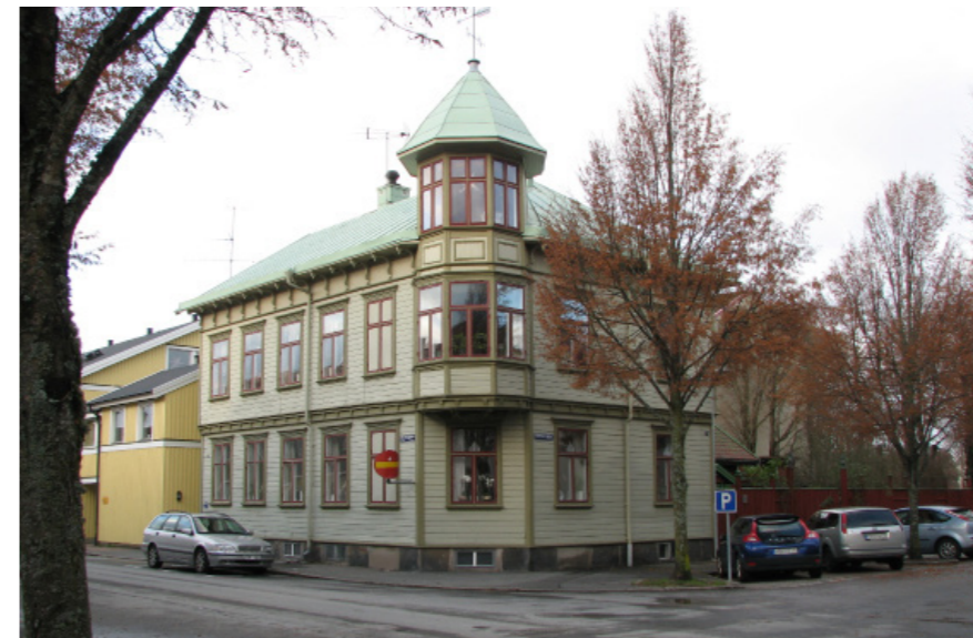
Ett återställt torn på Norden 3.
