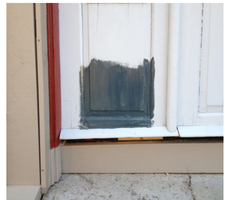
Framtagning av äldre färglager samt ommålning av dörr i kvarteret Hästskon.
