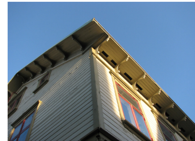
Panelarkitektur med liggande panel och profilsågade taktassar.
