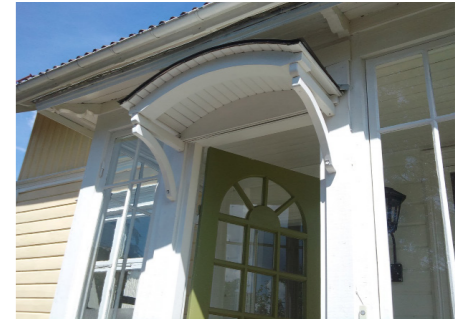
Entrédörr i glasveranda med påkostat skärmtak av trä från sekelskiftet.
