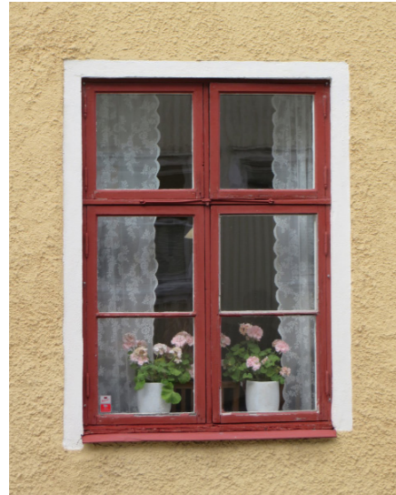
Ursprungligt fönster av korsposttyp i kvarteret Korpen.
