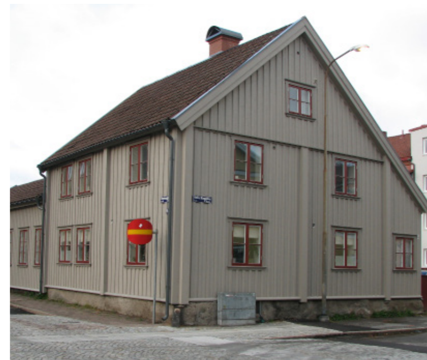
Ny färgsättning på två äldre hus i kvarteret Hästskon.
