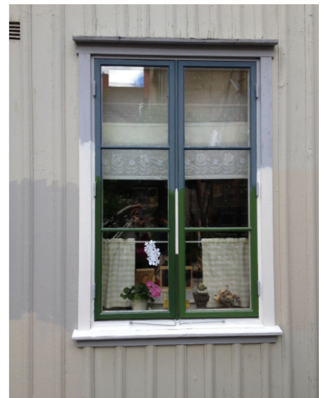
Provmålning av fasad och fönster på Cederberg 1, där en äldre färsättning hittats under befintligt färglager.
