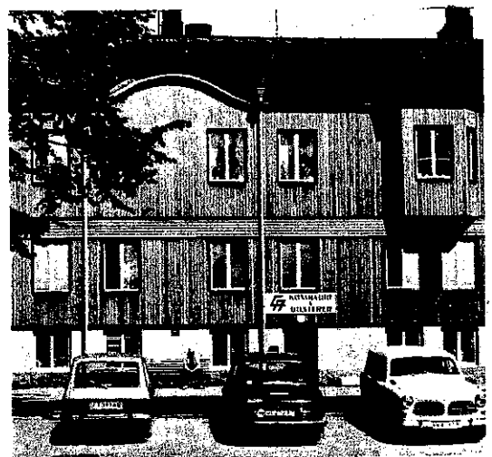
Utvändig tilläggsisolering förändrar karaktären och bör undvikas.
