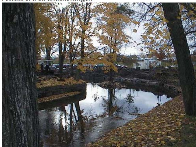
Lillåns krök vid kvarteret Bryggaren under arbetet med att restaurera strandskoningen
